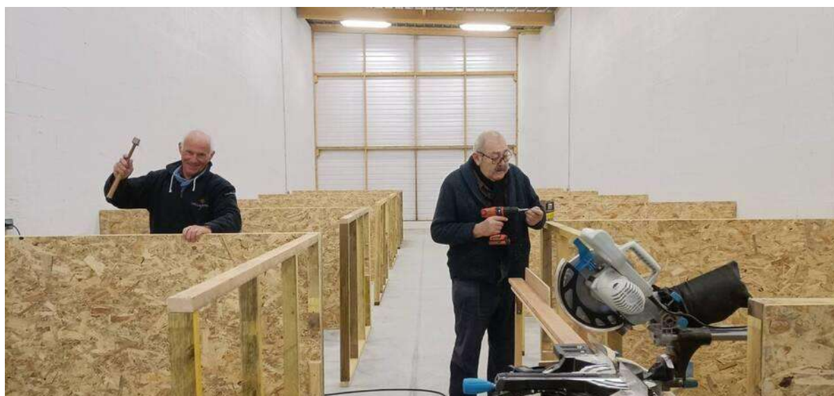
Pierre Robino (à gauche) et Jean-François Sérazin ont travaillé à consolider la structure des box.
