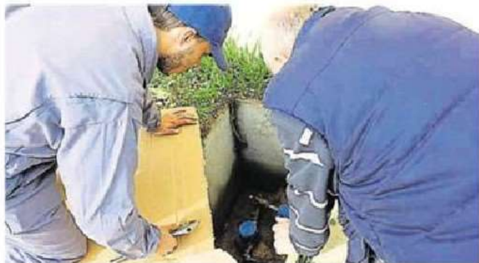
Segré, hier. Huit jeunes de l'Epide de Combrée ont été formés, par d'anciens plombiers, à démonter et remonter un compteur d'eau.
